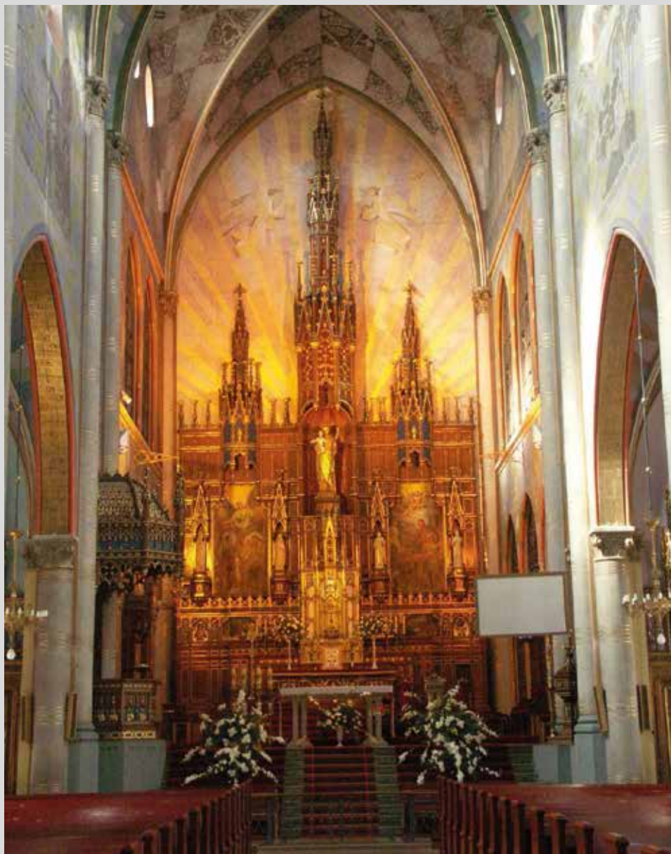
2. Widok ściany ołtarzowej i prezbiterium z dekoracją malarską S. Jakubczyka. Zły stan zachowania malowidła: zabrudzenia, częściowa utrata czytelności na skutek korozji spoiwa i pudrowania się dekoracji spowodowanych okresowymi zawilgoczeniami i zasoleniem podłoża [archiwum Art Forum]
