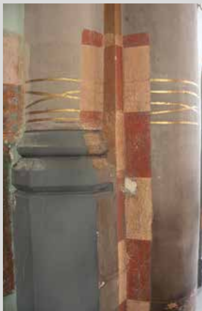
4. Odkrywka płaszczyznowa malowidła M. Ceradiniego na filarach i półkolumnach [archiwum Art Forum]
