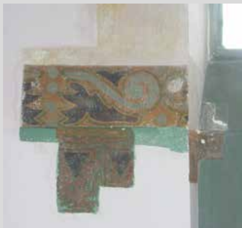
6. Odkrywka płaszczyznowa malowidła M. Ceradiniego – pas lamperii [archiwum Art Forum]
