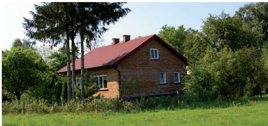
Zdjęcie 2. Dom jednorodzinny w okolicach Siedlec przewidziany do głębokiej termomodernizacji (zdjęcie: KAPE S.A).
